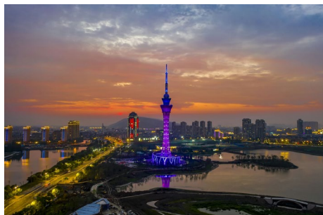
常熟市電視塔
