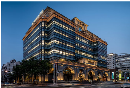
台北 泰安產險大樓
